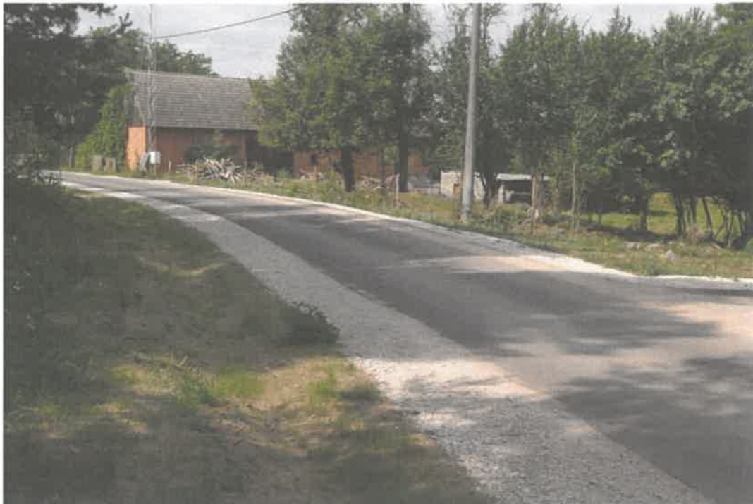
Droga w Mieczkowie, etap I zakończony
