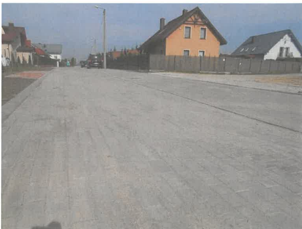
Ulica Kwiatowa w Kcyni po remoncie
