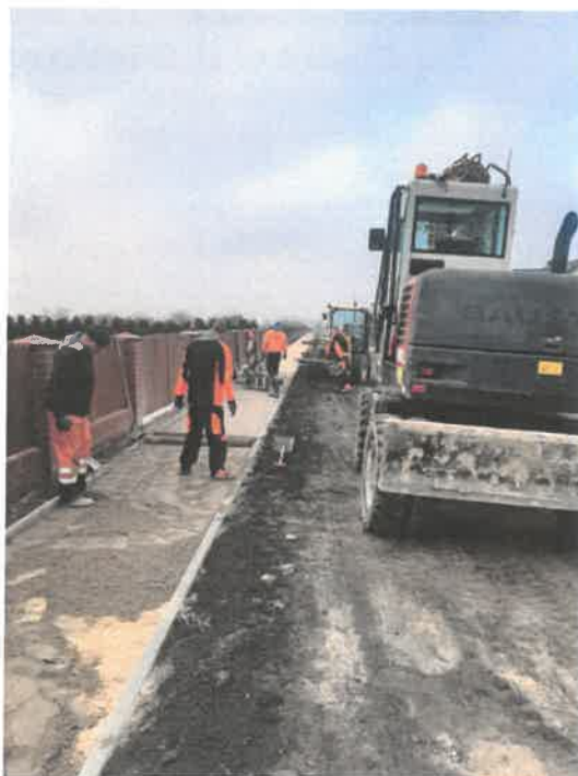
Budowa chodnika na ul. Wyrzyskiej
