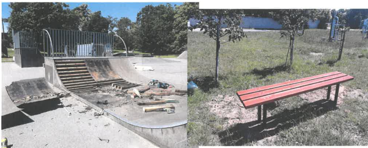
Remont uszkodzeń stelaża skate-parku
