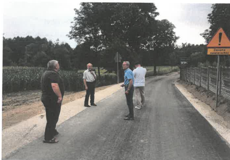
II etap budowy drogi w Mieczkowie
