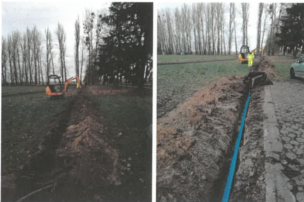
Budowa przyłącza elektroenergetycznego do kortu tenisowego
