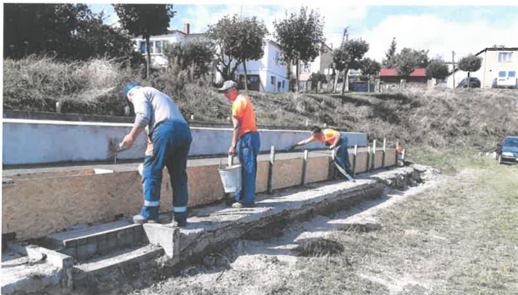
Remont trybun przy boisku przy ul. Powstańców Wielkopolskich
