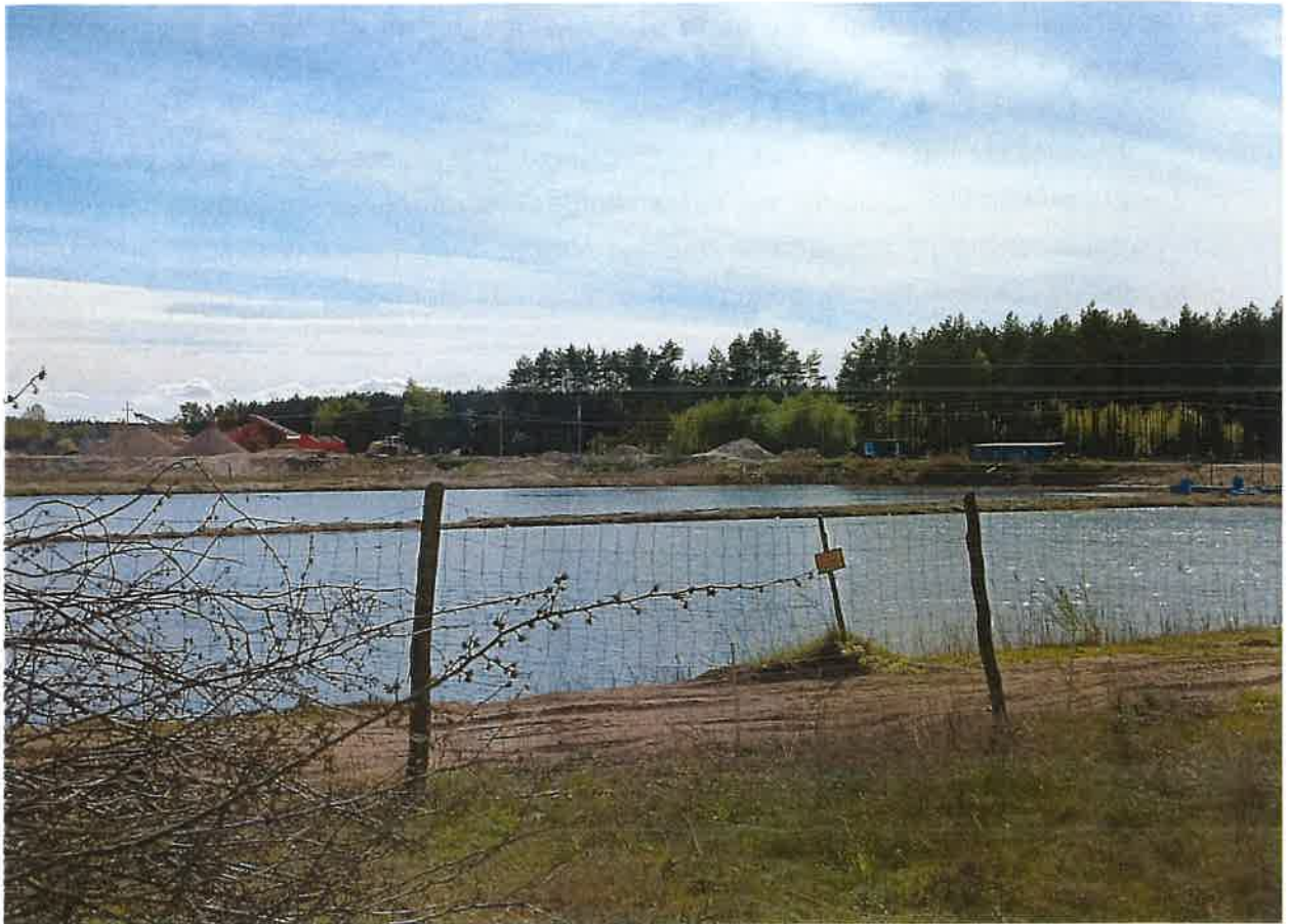
Fot.11: Żwirownia Mieczkowo – zbiorniki ogrodzone
