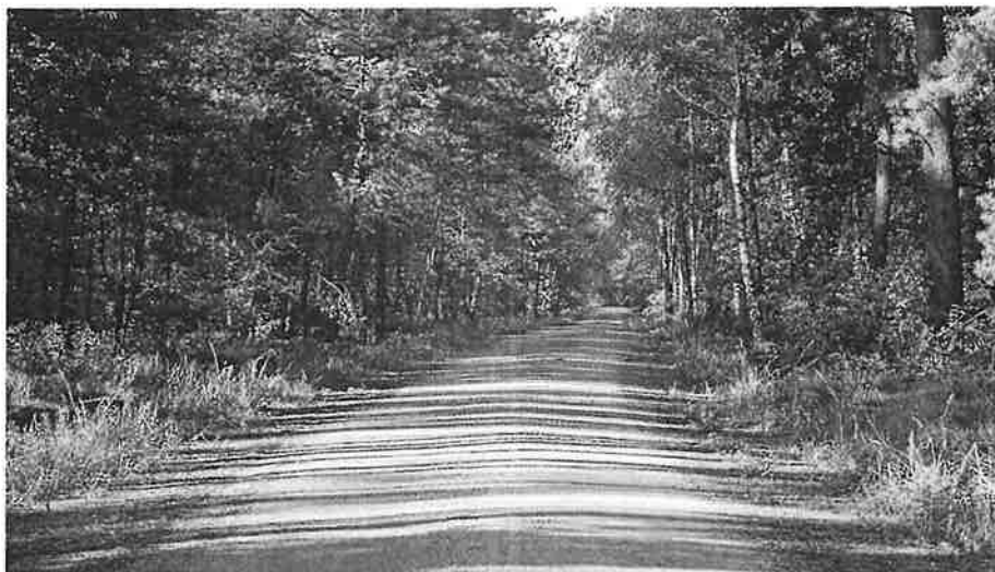
Dojazd pożarowy nr 9 Leśnictwo Gąbin – Łabiszyn Koszt inwestycji 712 598 zł 6,15 km - Gmina Łabiszyn.
